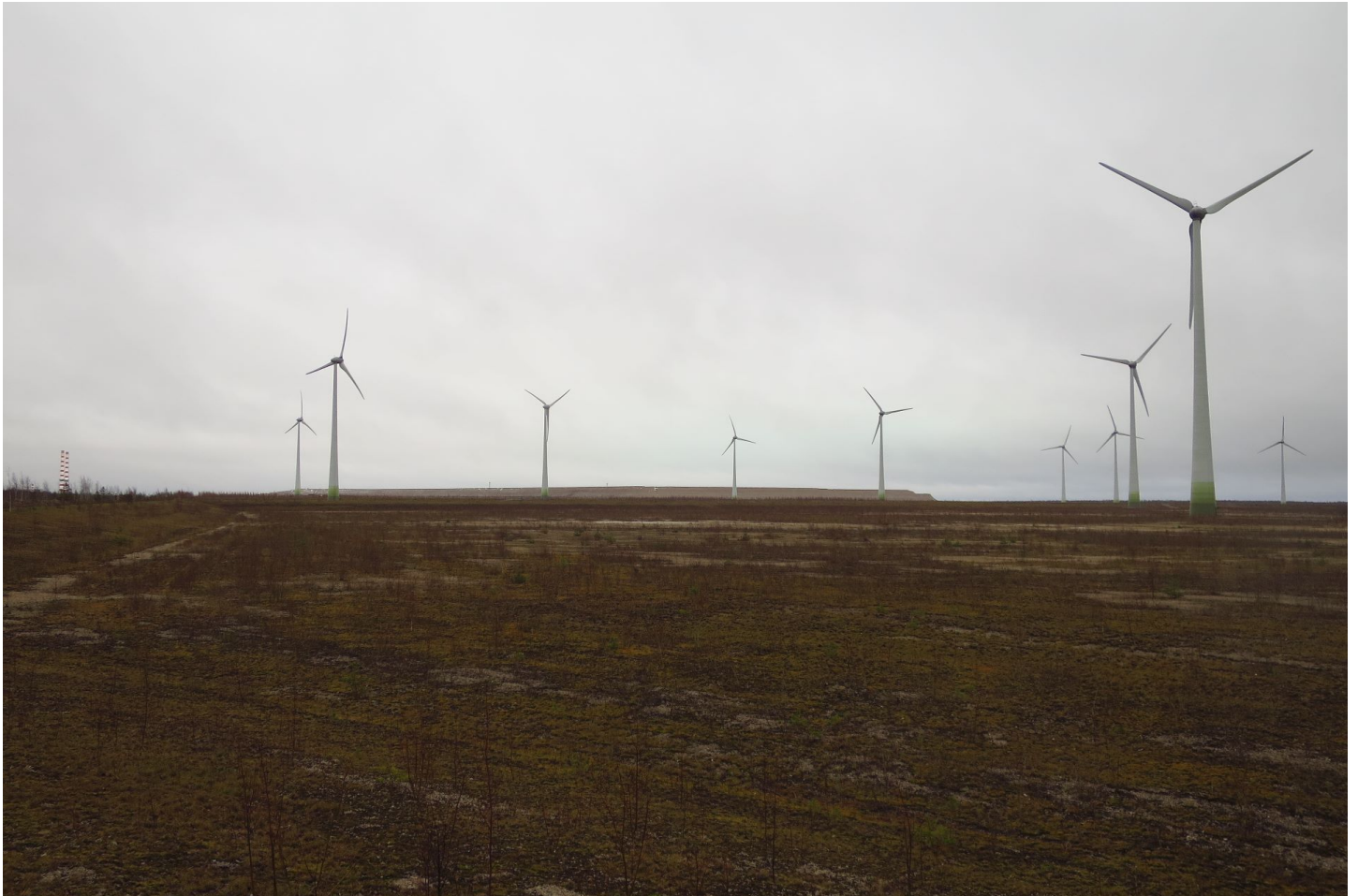
Balti Elektriijaama suletud tuhaväljale nr. 2 on rajatud tuulikupark. Taustal paistavad elektriijaama korstnad ja töötav tuhaväli nr. 1 (Marko Vainu)
