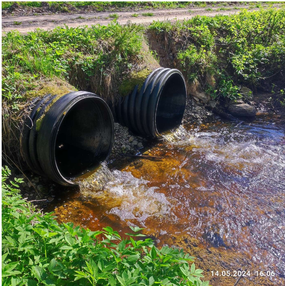
Pilt 6. Kiva külas Kunda metskond 10 kinnistul (KÜ 88703:002:1490, Kiva küla lähistel loodesuunas ja Kaarli talu ning Kandle vahelist jõelõiku ületaval teel Kandlelt põhjasuunas) on paigaldatud uued plastist teetruubid, mis tekitavad allavoolupoolses otsas 0,15 m kõrguse astme. Koordinaadid: XY: 6599973.20, 627899.10. Autor: Geidi Rõõm
