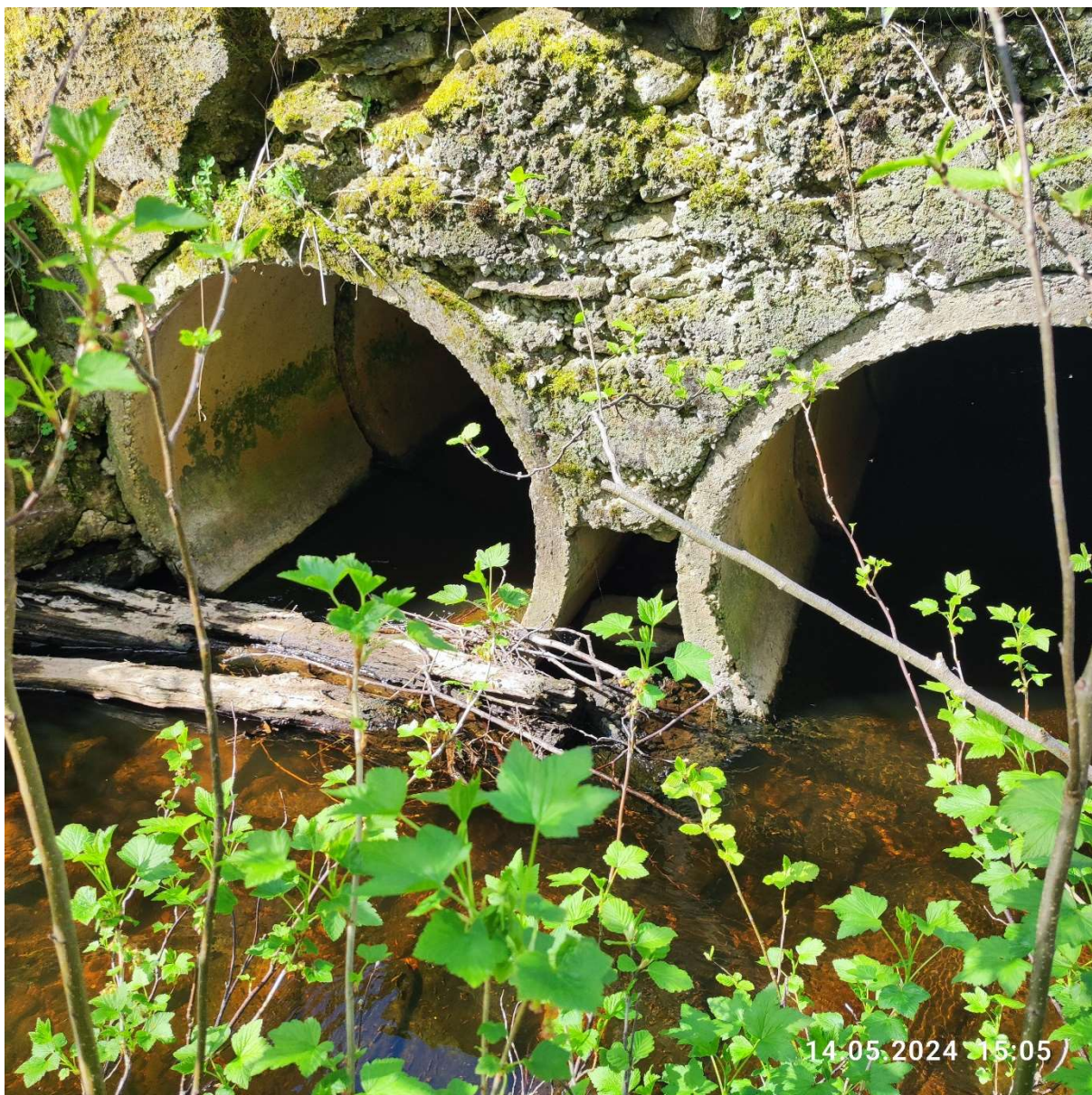
Pilt 10. Kruuskattega tee all olev truup, mille ees oksarisu. Enne truupe on erakinnistul tiik (paistab, et jõega ühenduseta) ja jõkke suubuv kraav. Koordinaadid: XY: 6598886.99, 628193.61. Autor: Geidi Rõõm
