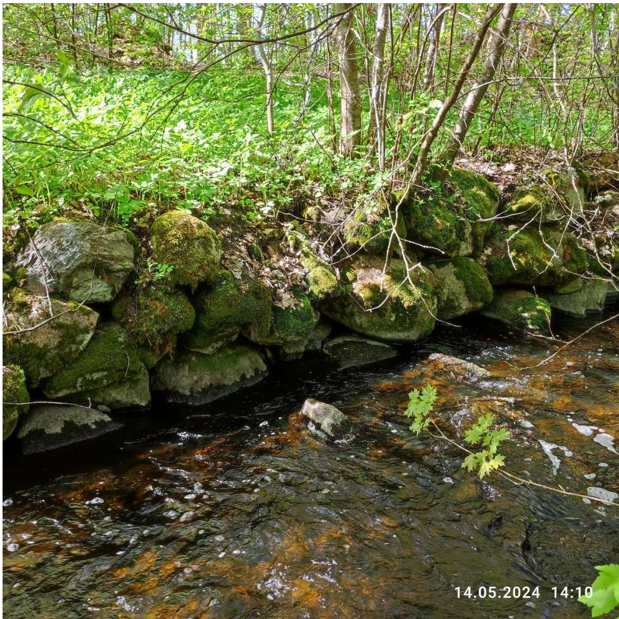
Pilt 5. Vasakkallas on ca 20+ m ulatuses kividega kindlustatud. Ligikaudsed koordinaadid: XY: 6598445.78, 628229.48. Autor: Geidi Rõõm
