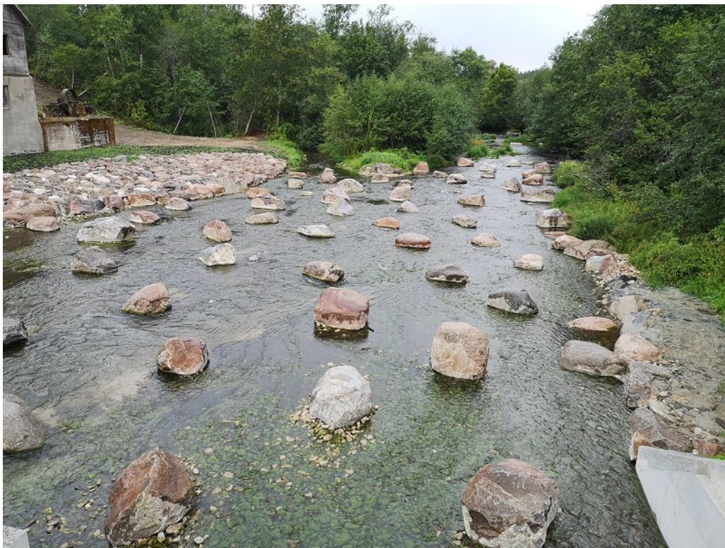
Foto 4. Vaade allavoolu Varangu kalapääsule, ca 15,5 km merest. Suuremate kivide vahel peaks olema ka keskmise ja väiksema suurusega kive. Praegu näeb kärestik välja väga tehisklik (R. Järvekülg, 31.08.2022).
