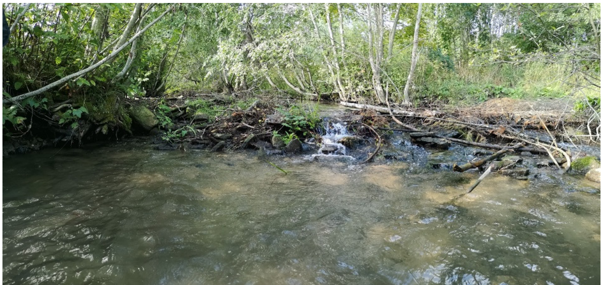
Foto 14. Selja jõgi ca 41,9 km merest. Jõkke on paekividest ja -killustikust rajatud koolmekoht, millega on jõge ca 0,5 m paisutatud. Paisutus tuleb likvideerida (R. Järvekül, 09.09.2022).
