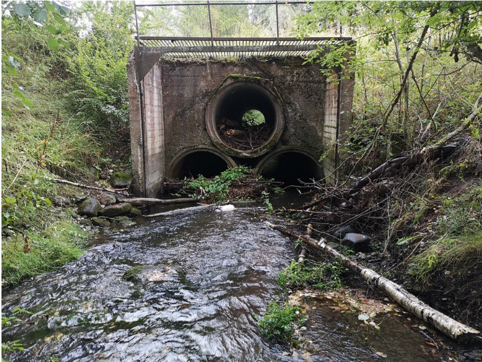
Foto 15. Paatna – Veltsi tee truup, ca 42,3 km merest. Selline 3-avaline truup korjab risu ja aegajalt ummistub. Samas pole siinkohal tegu nii suure probleemiga, et kohe uut truupi peaks rajama hakkama. Mõistlik oleks edaspidi siiski selliste truupide asemel rajada ühe-avalisi torutruupe (R. Järvekülg, 31.08.2022).
