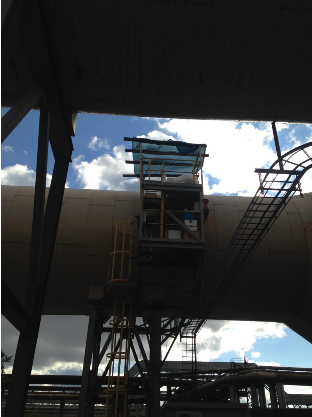
Joonis 6 Proovivõtukoht EE keevkihi katla suitsukäigust
