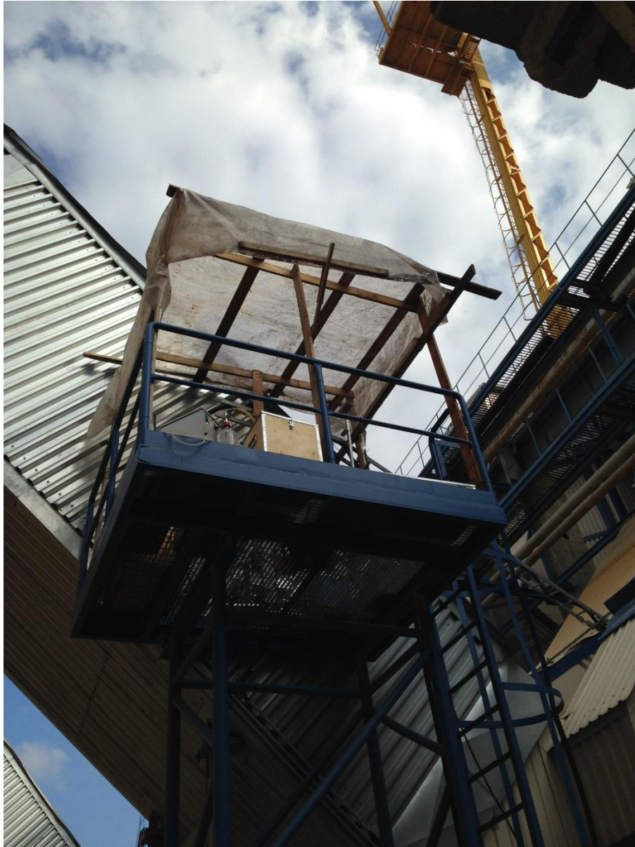
Joonis 7 Proovivõtukoht EE tolmpõletuskatla suitsukäigust
