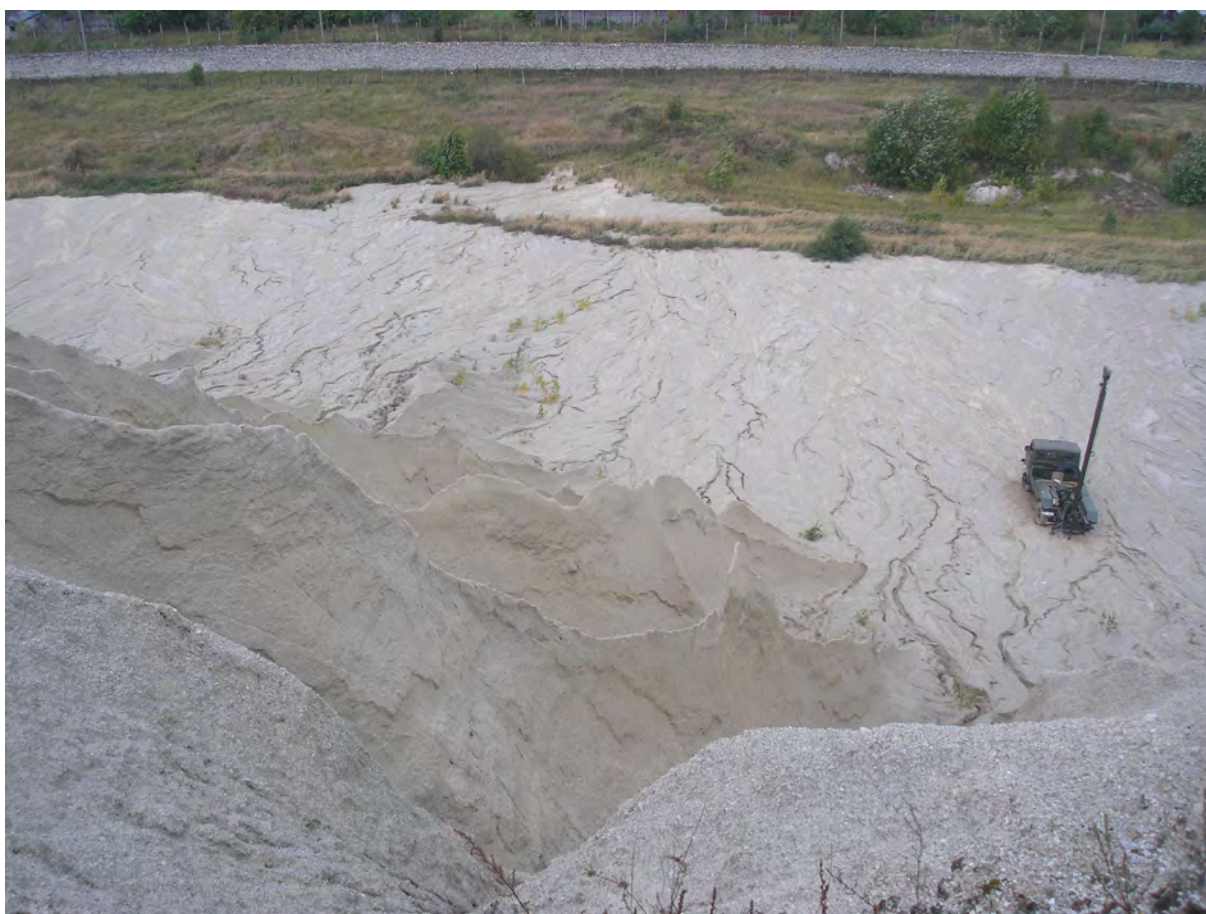
Foto 1 Rummu kaevandamisjäätmeoidlal on järsud nõlvad ja peenmaterjal kandub sademetega laiali (2007 a fotod)
