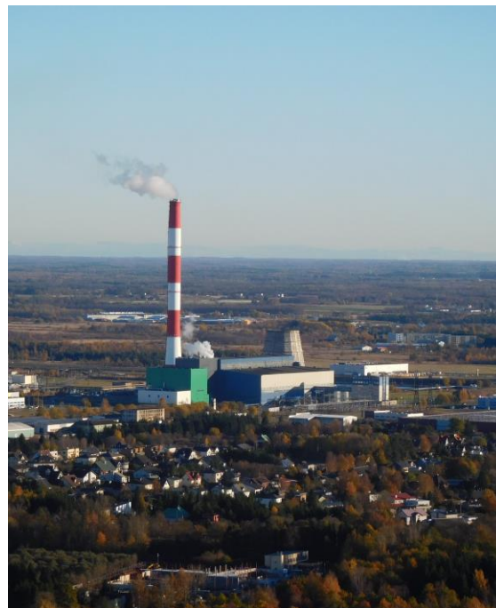
AS Eesti Energia Iru jäätmeenergiaplokk
